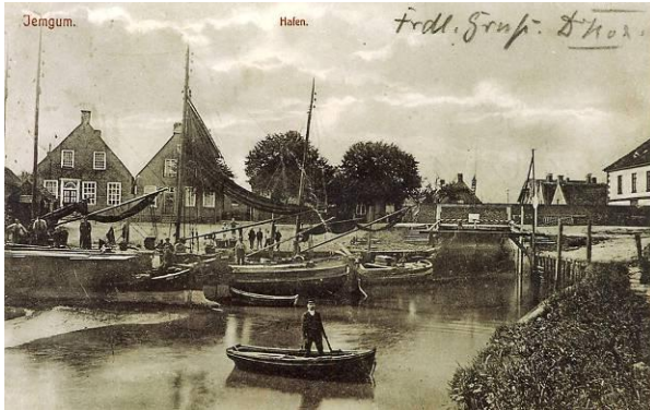
Abbildung 7: Historische Aufnahme des Sielhafens von Jemgum
