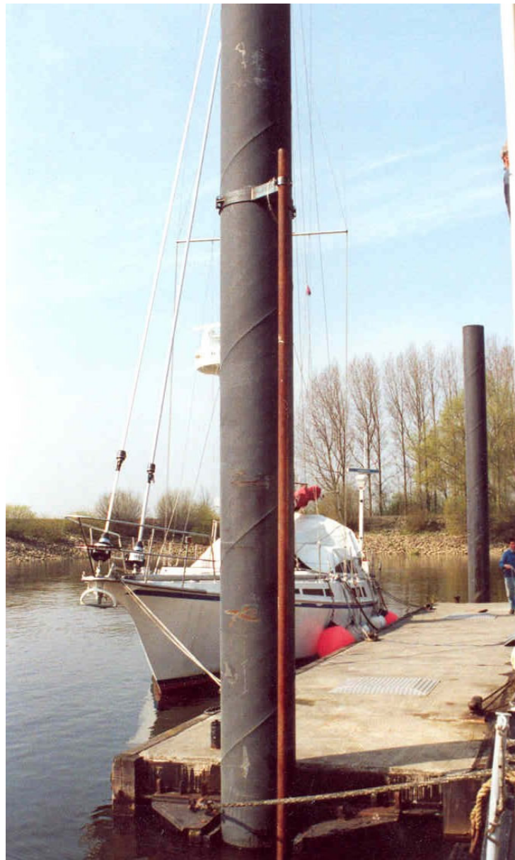
Abbildung 4 Montage eines Hilfsrohrs
