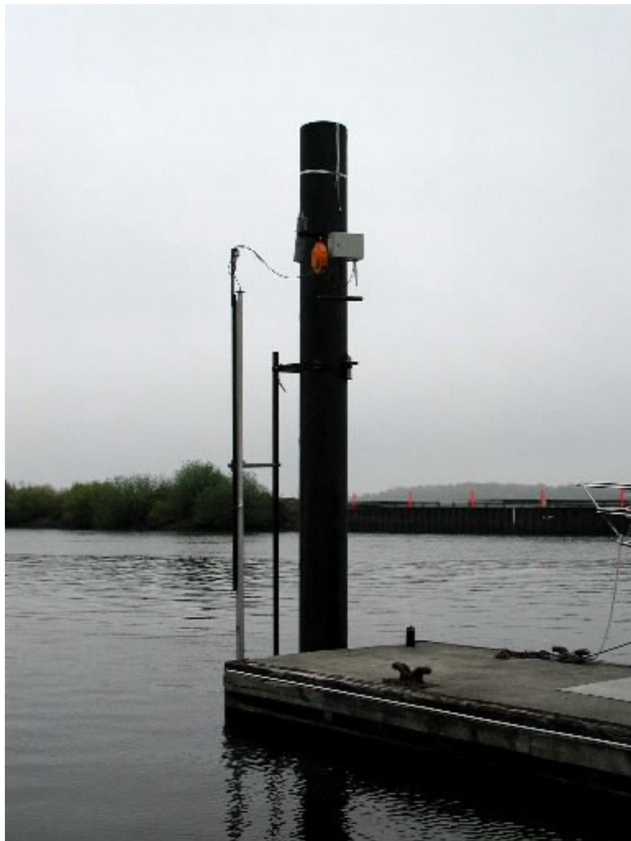
Abbildung 6 Blick von Schlängel M in Richtung westliche Hafeneinfahrt
