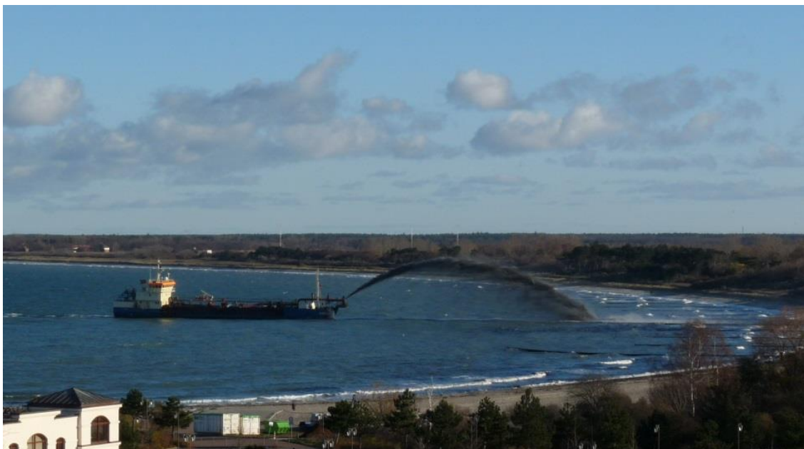
Abbildung 10: Nutzung von Baggergut im Rahmen des Küstenschutzes (Unterhaltungsbaggerung 2013), Foto: WSA Stralsund
