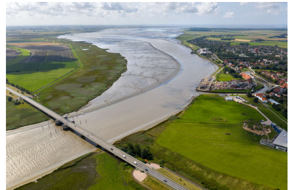
Eiderbrücke bei Tönning, Quelle: BAW 08/2019
