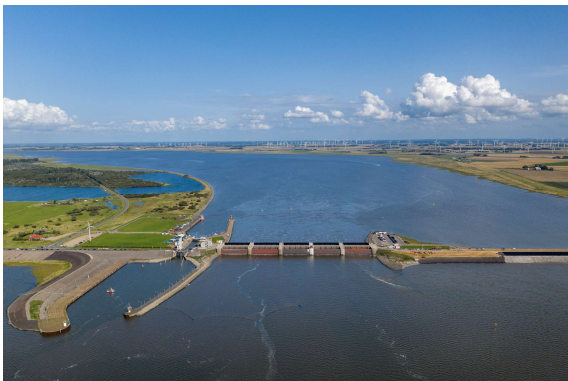
Eider-Sperrwerk, Quelle: BAW 08/2019
