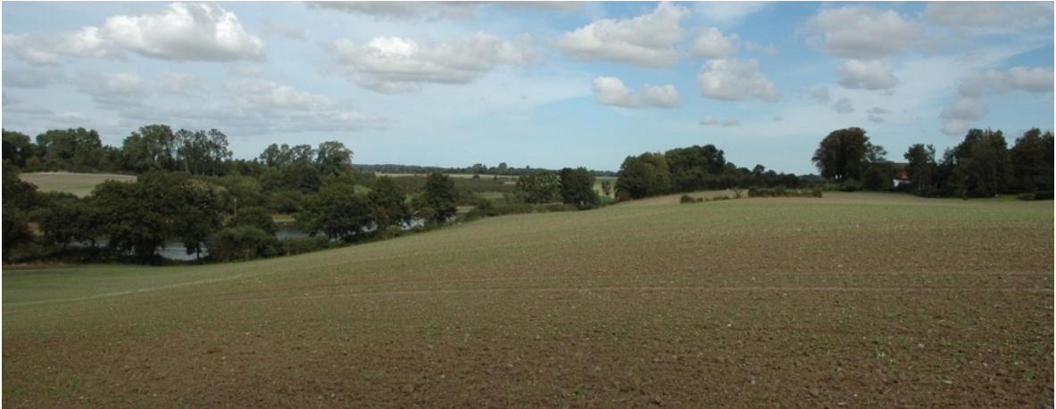
Abb. 5-13: Blick nach Norden auf den Kanal im Bereich der Baulose 1 und 2 östlich von Landwehr Ist-Zustand
