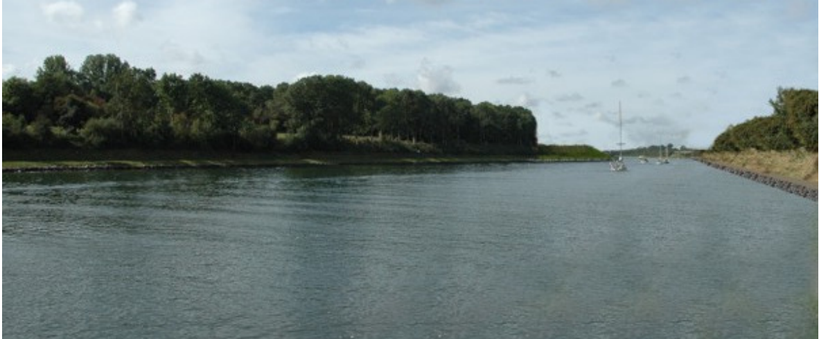
Abb. 5-16: Blick von Baulos 3 aus nach Westen auf den Kanal im Bereich von Baulos 2 Prognose: Zustand im Sommer
