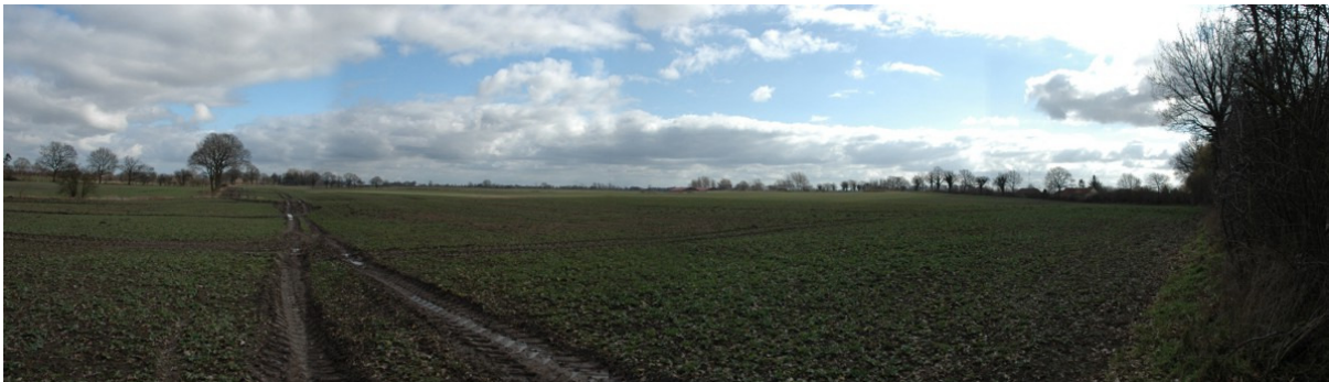
Abb. 5-3: Blick nach Süden auf die geplante Verbringungsfläche Warleberg-Zentral Ist-Zustand
