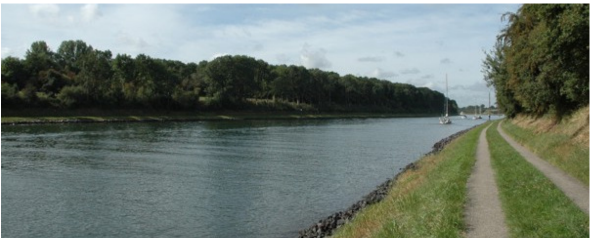
Abb. 5-15: Blick von Baulos 3 aus nach Westen auf den Kanal im Bereich von Baulos 2 Ist-Zustand
