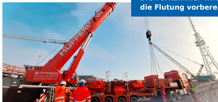
Schweres Gerät: Bevor der Rückbau des Mischwerks beginnen kann, wird ein spezieller Kran errichtet.
