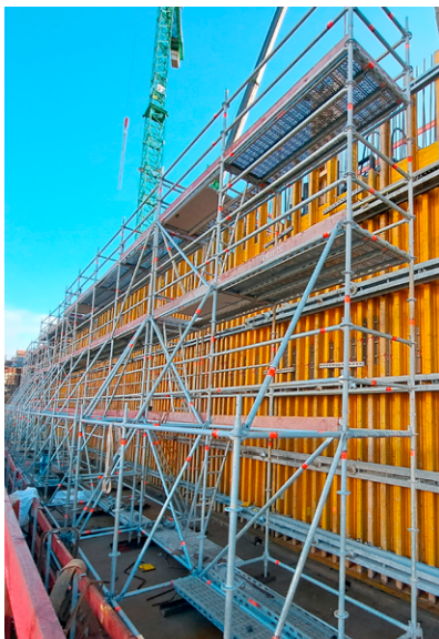
Auch die Schalungsarbeiten werden abschnittsweise durchgeführt.
