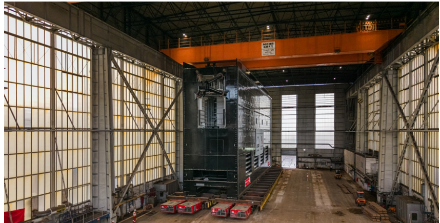
Giganten unterwegs: In Emden wurden die jeweils rund 2.200 Tonnen schweren Schleusentore aus der Montagehalle auf die Freifläche transportiert.
