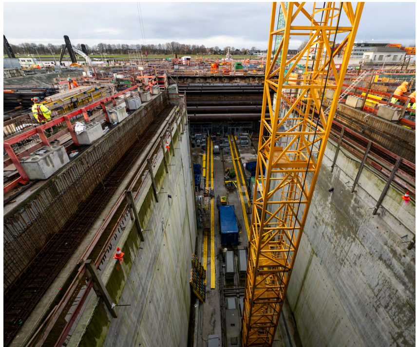
In der Kammersohle sind die Schienbahnen erkennbar, auf denen sich später die Unterwagen bewegen.
