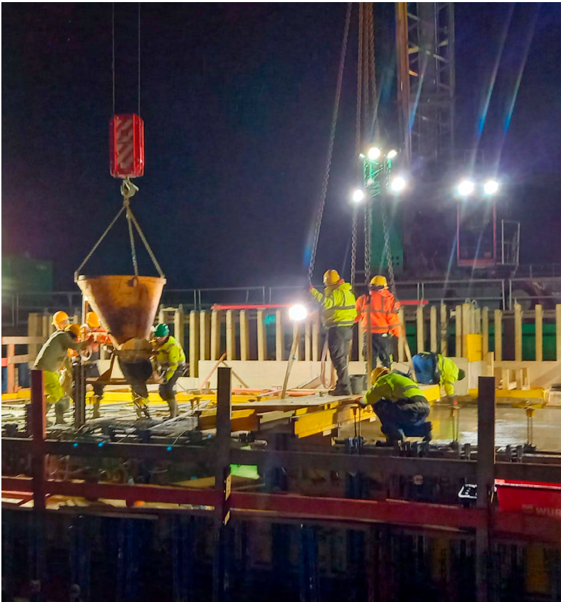
Mit vollem Körpereinsatz arbeitet das Team an der Betonage des Toranschlagpfeilers.
