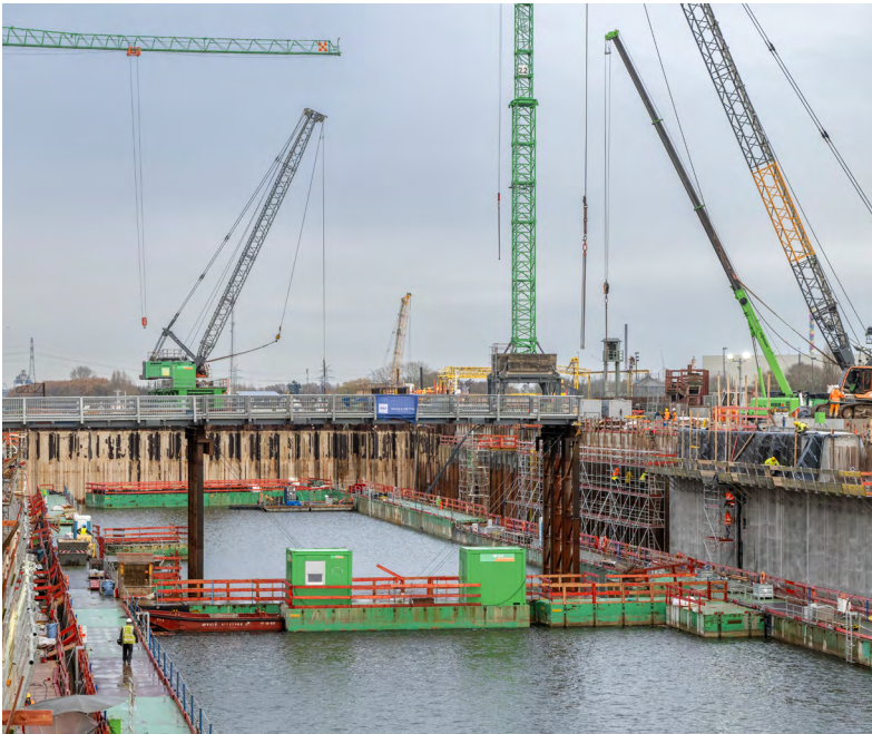
Dank der Stahlbaubrücke können Baustellenverkehre jetzt die Schleusenammer queren.
