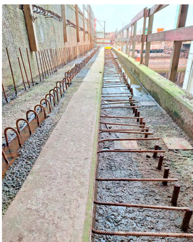
Bewehrung vor dem Einbau von Kettenführung und Oberwagenschienen.
