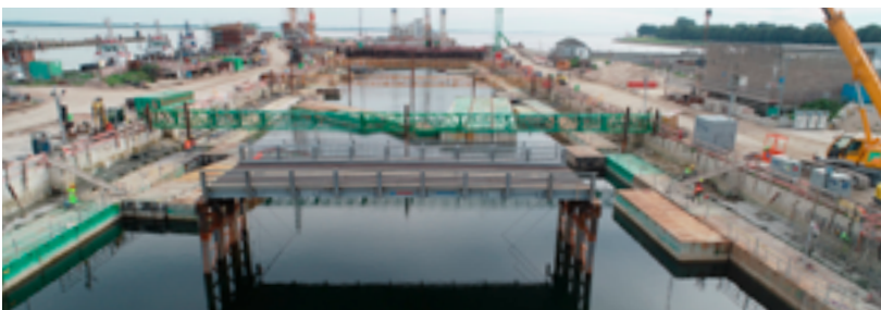
Mit einer neuen Stahlbaubrücke können Baustellenverkehre die Kammer bald queren.
