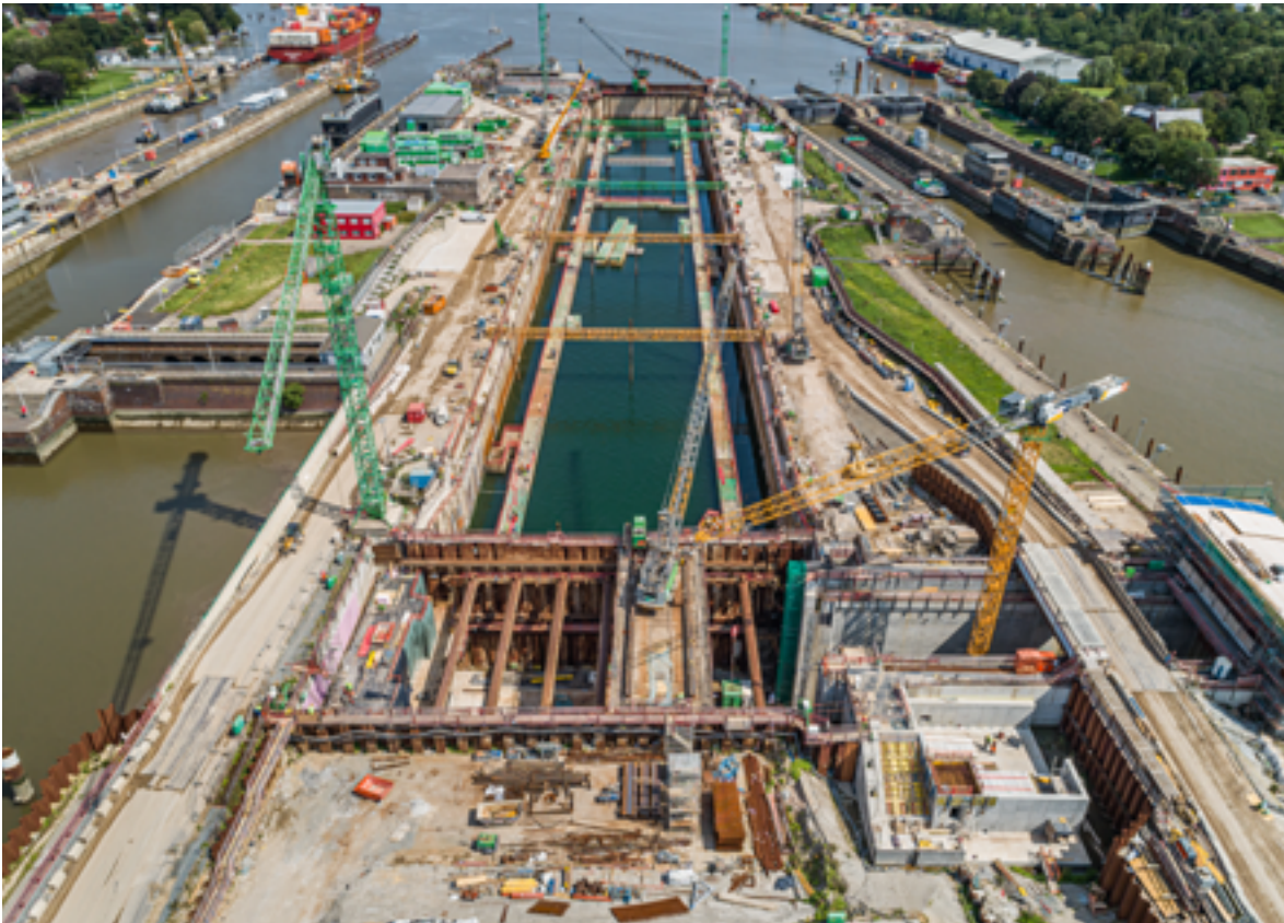
Blick auf die Schleusenammer: im Vordergrund die Baugrube des Außenhaupts, im Hintergrund der Nord-Ostsee-Kanal.
