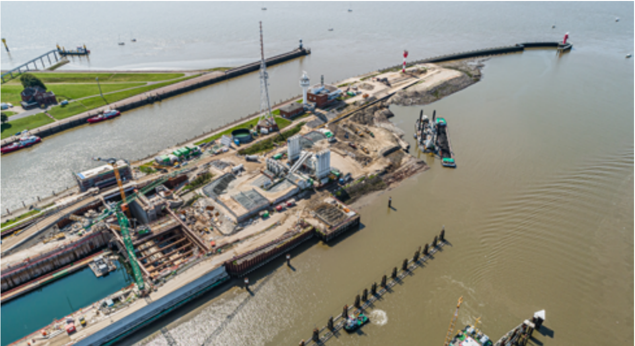
Nur wenige Meter vom Betonmischwerk entfernt tragen zwei Bagger an Bord des Arbeitsschiffs „Scheldeoord“ rund 14.000 Kubikmeter Boden ab.
