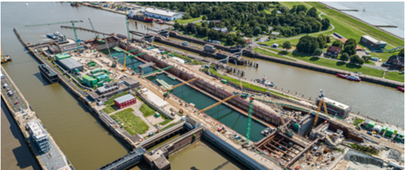
Erkennbare Fortschritte an vielen Bauteilen: im Zentrum die Schleusenammer mit abgesenktem Wasserstand.
