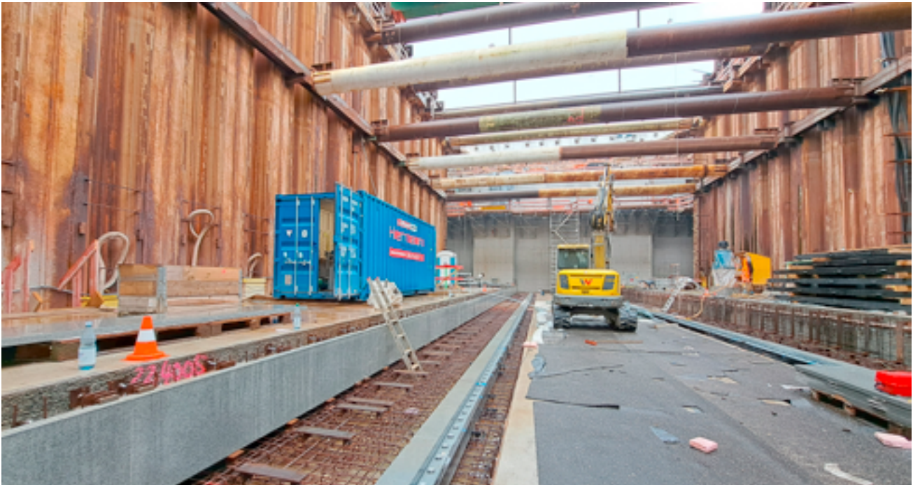
Warten auf den Zweitbeton: In der Sohle des Binnenaupts sind die vertikalen Granitplatten entlang des linken Schienenverlaufs bereits platziert.
