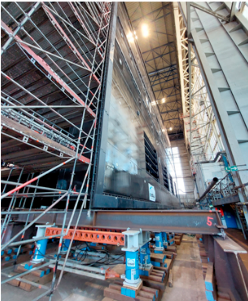
Aufwendige Technik: Jedes Schleusentor wird mit Hilfe von 128 Hydraulikpressen verwoagen.
