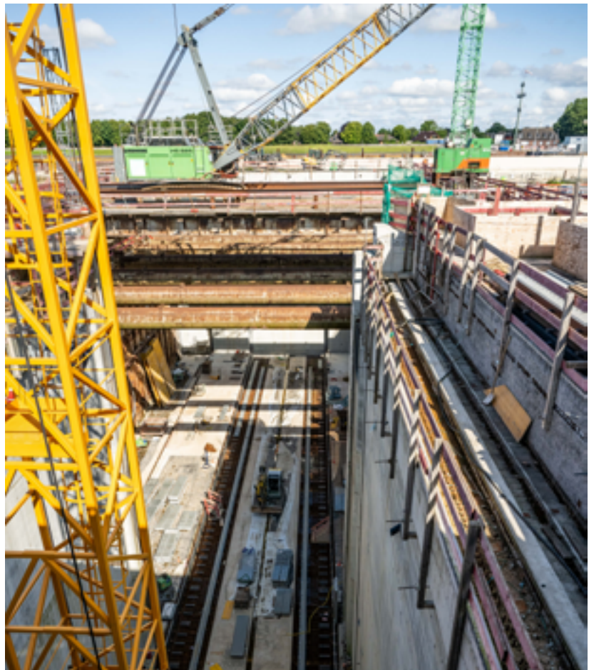
Blick auf die Schienenkonstruktion in der Torkammer des Außenaupts in Richtung Drempel.
