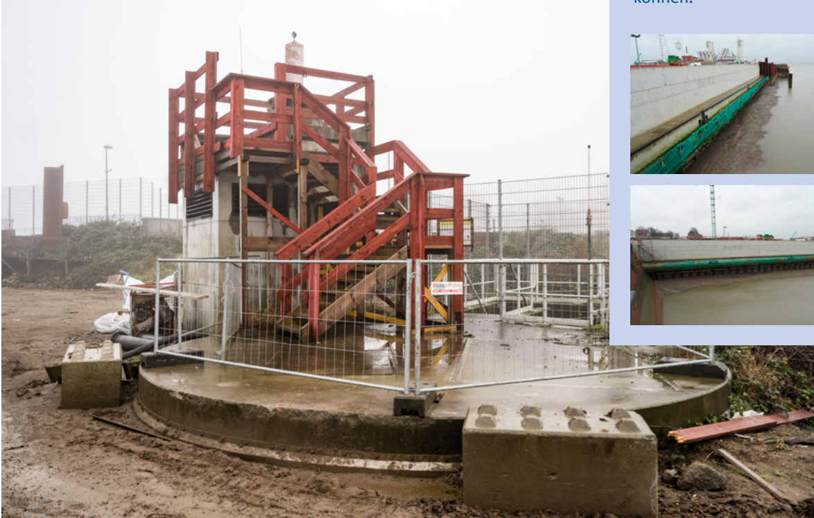
Die Zwischenschacht-Abdeckung des unter der Schleusenanlage verlaufenden Rohr- und Kabeldükers bietet einem Messpunkt für die baubegleitende Vermessung einen erhöhten Standort.
