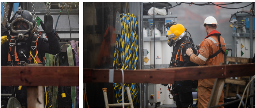
In der Schleusenammer laufen die Vorbereitungen für den nächsten Meilenstein: die Betonage der Kammersohle ab Mitte des Jahres.
