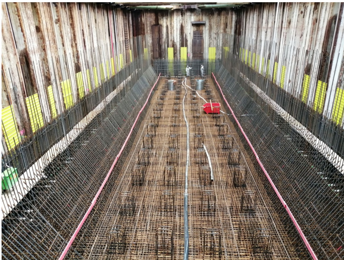
Blick in die Baugrube der Außenhaupt-Torkammer Anfang Januar: Die Vorbereitungen für die erste Betonage der Konstruktionsbetonsohle sind fast abgeschlossen.
