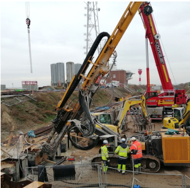
Mit schwerem Gerät werden die Düsenstrahlpfähle in schrägem Winkel in den Boden eingebracht.
