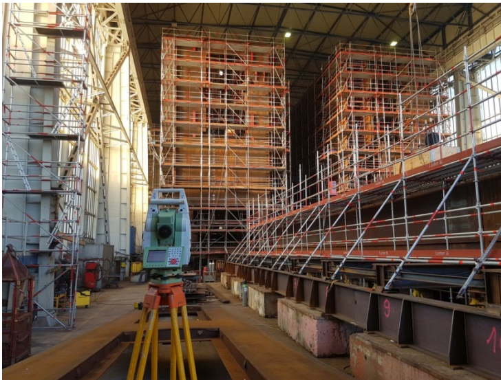
Blick auf die eingerüsteten Schiebetore VII und VIII mit den ersten Segmenten von Tor IX rechts im Vordergrund...
