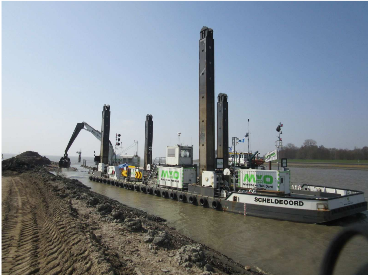
Beginn der ersten großen Nassbaggerkampagne für den Rückbau der vorderen Schleuseninsel (April 2018).
