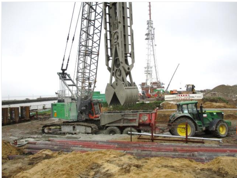
Schlitzwandarbeiten an der südlichen Baugrubenstirnseite des Außenhauptes
