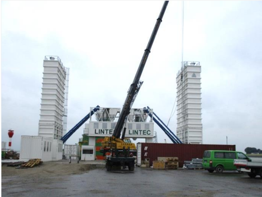
Aufstellen der Zementsilos der Betonmischanlage
