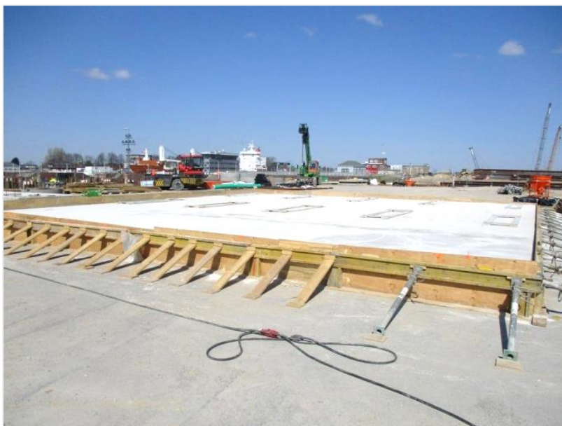
Fundamentplatte der Betonmischanlage
