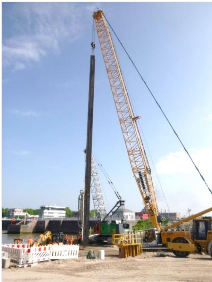
An der nördlichen Stirnseite des Außenhauptes der Baugrube werden Tragbohlen eingebaut.
