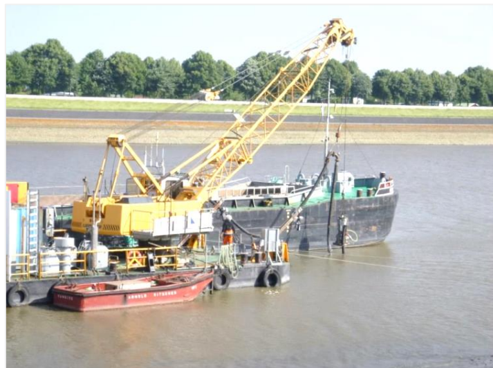
Identifizierte Verdachtspunkte werden frei gespült und untersucht.
