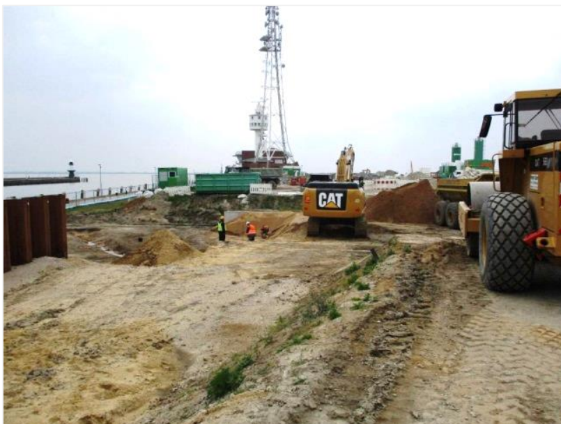
Die Arbeitsebene für die Schlitzwandarbeiten am Außenhaupt wird hergerichtet.
