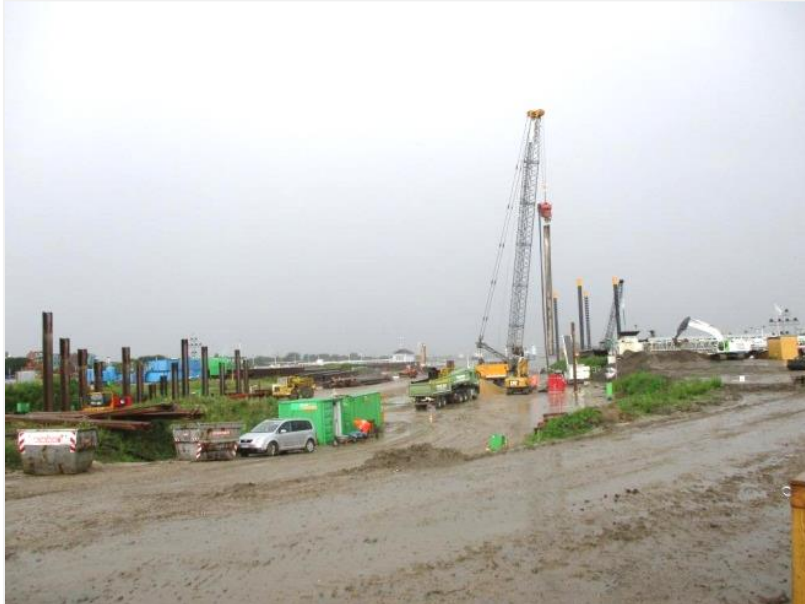
Einbau der Tragbohlen an der südlichen Kammerwand
