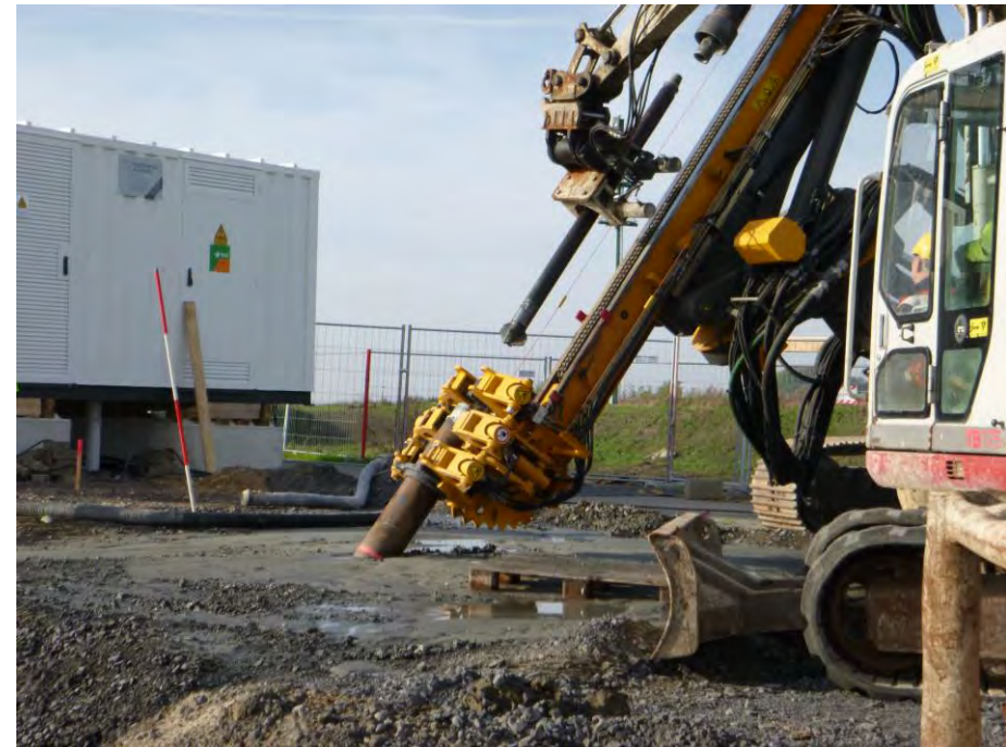
Abb. 9 Hier ist der Einbau des Düsgestänges zu erkennen.
