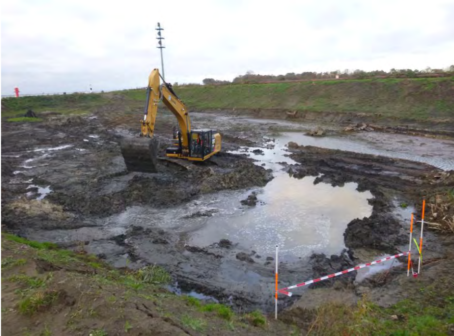
Abb. 13 Der ehemalige Teich wird durch eine Volumenräumung auf Kampfmittel untersucht.
