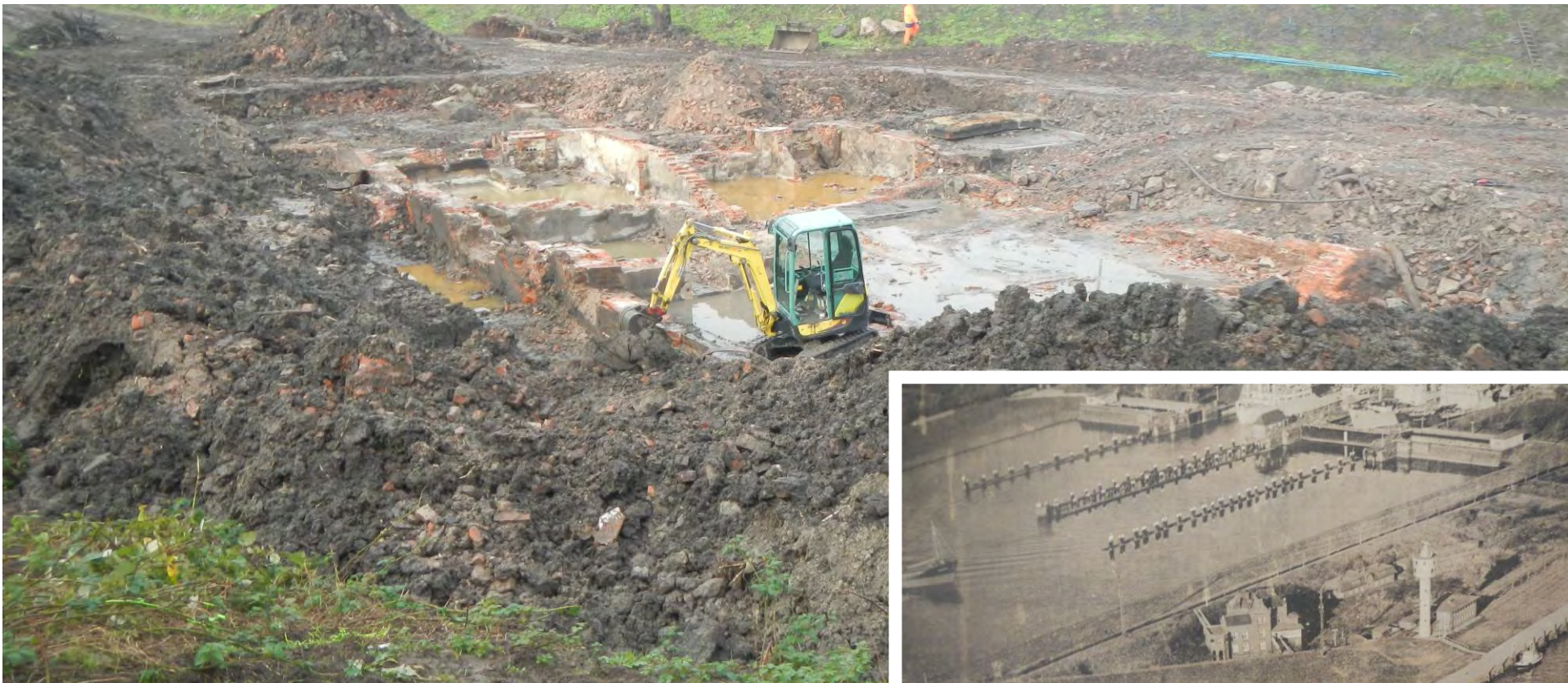
Abb 15 Bei der Kampfmitteluntersuchung werden Fundamente eines ehemaligen Gebäudes im Bereich des Teiches freigelegt.
