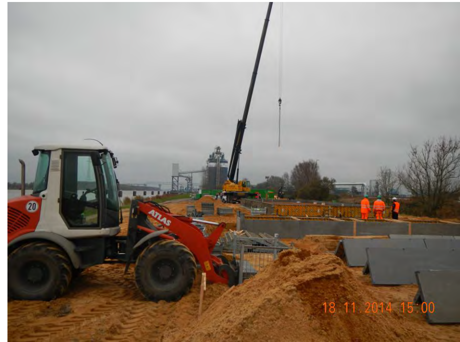
Abb. 4 Für die Bürocontaineranlage werden die erforderlichen Fundamente errichtet.
