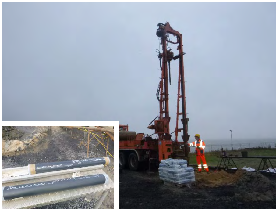
Abb. 5 Im Rahmen vorgezogener Pfahlprüfungen werden Baugrundaufschlüsse (Bohrungen) zum Vergleich mit den Baugrundaufschlüssen im Baufeld der geplanten Schleuse ausgeführt.
