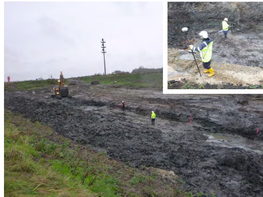
... Abb. 14 Für die Oberflächenerkundung wird ein sondierfähiger Horizont (auswertbare Fläche) hergestellt.
