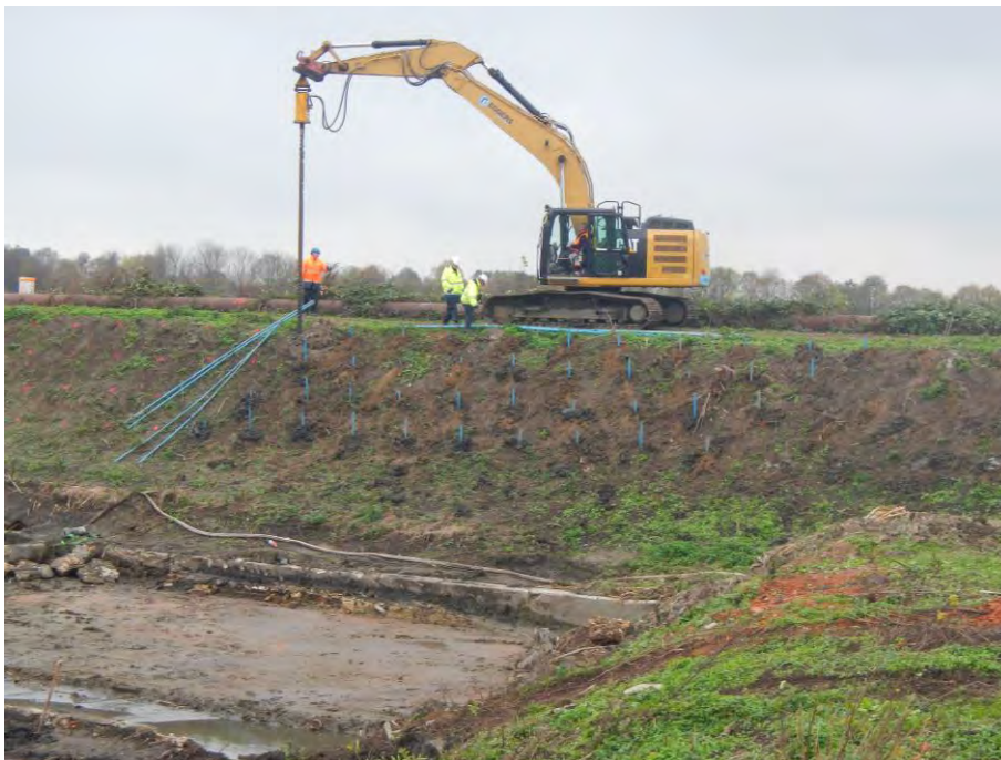
Abb. 11 In den Böschungsbereichen werden Sondierbohrungen durchgeführt.
