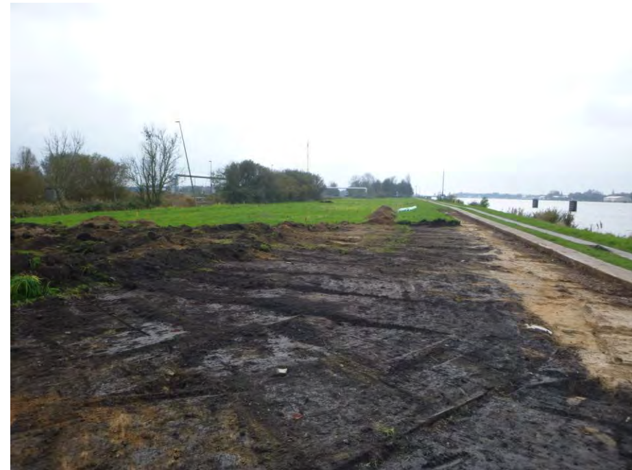
Abb. 2 Auf dieser primären Baustelleneinrichtungsfläche (BE-Fläche) wird die Arbeitsgemeinschaft (ARGE) für den Bau der Schleusenkammer, die aus den Firmen Wayss & Freytag Ingenieurbau AG, BAM Civiël bv Gouda (Niederlande) sowie Wayss & Freytag Spezialtiefbau GmbH besteht, ihr Baubüro errichten. Außerdem dient die BE-Fläche der Abwicklung der Landtransporte und Umschlagsarbeiten von und zur Baustelle auf der Schleuseninsel.
