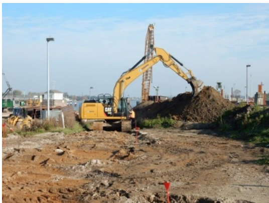
Vorbereitende Erdarbeiten für die Kampfmittelsondierung
