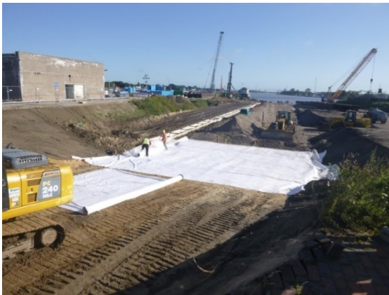
Bau der Leitwand für die nördliche Kammerwand
