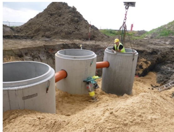
Einbau der Entwässerungsschächte
