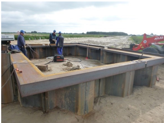
Bau der Pumpstation 1
