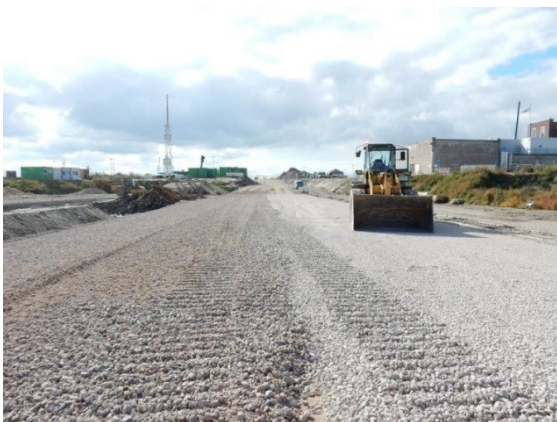
Anschließend werden die Baustraßen mit bis zu 1m dicken grobkörnigen Tragschichten aufgebaut.
