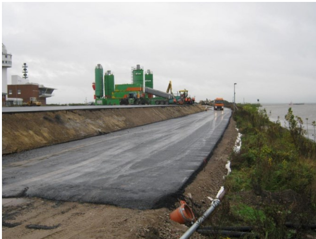
Den Oberflächenabschluss der Baustraßen bilden Asphaltdecken.
