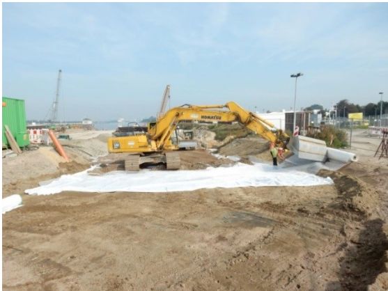
Auf dem vorhandenen Untergrund aus Klei wird zunächst ein zugfestes Geotextil in den Trassen der Baustraßen verlegt.
