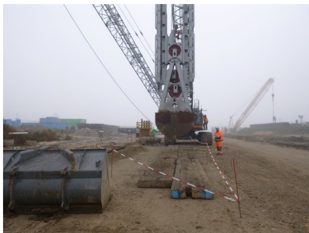
Schlitzwandgreifer beim Aushub des Probeschlitzes
