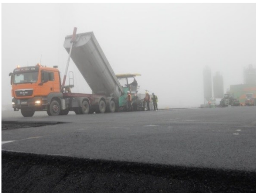
Asphaltarbeiten für die Arbeitsebene der Betonmischanlage
