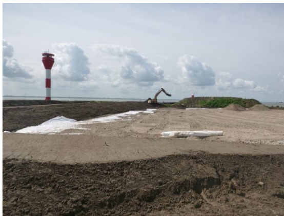
Einbau der Foliendichtung und Basisdränschicht in der Bereitstellungsfläche für den Bodenaushub
