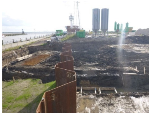
Erdarbeiten Leitwand Außenhaupt
