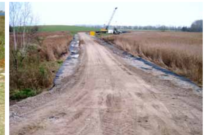
Abb. 3: Baustraße in der Trasse des Flügeldeiches, Blickrichtung vom Seedeich landeinwärts
