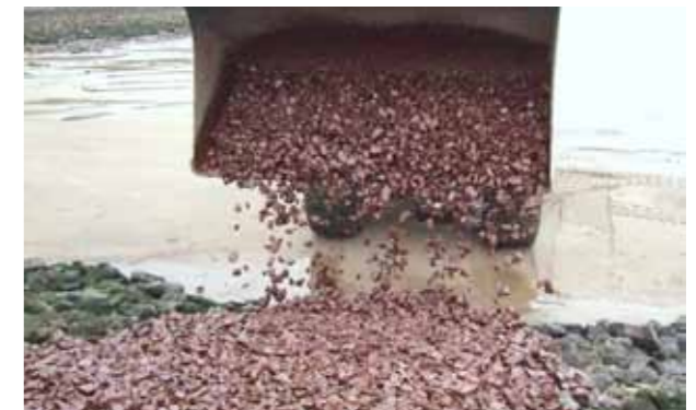
Abb. 4: Aufbringen der Deckschicht
