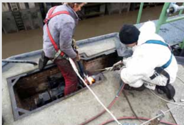
Abb. 1: Lösen Halslager
