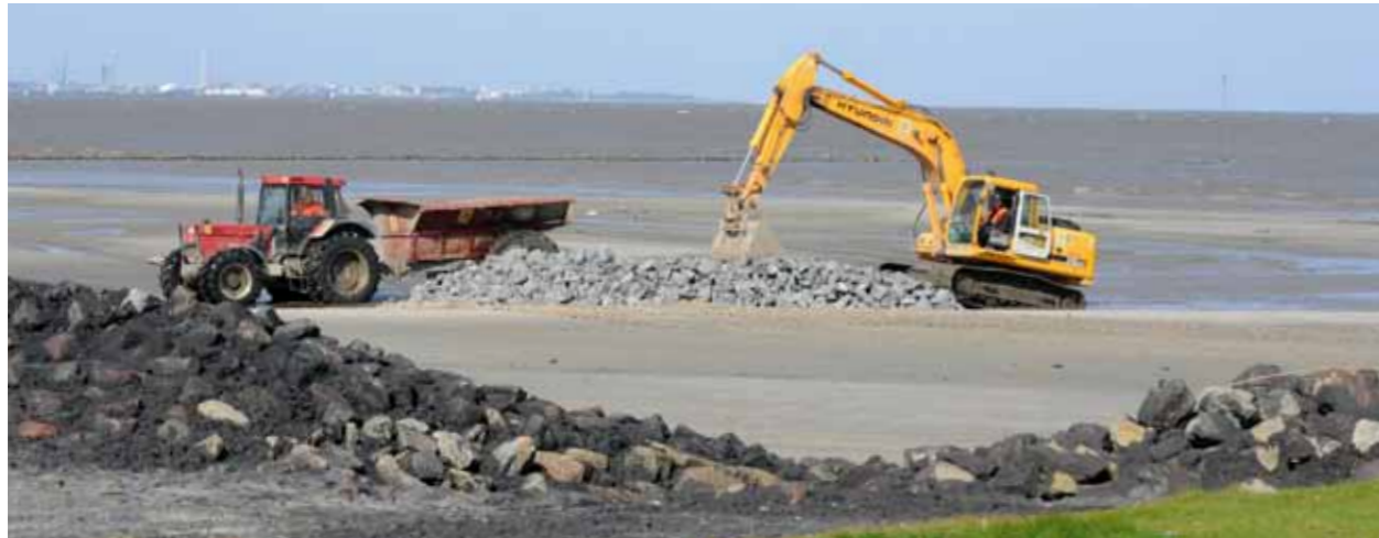
Abb. 3: Ufersicherung am Altenbrucher Bogen
