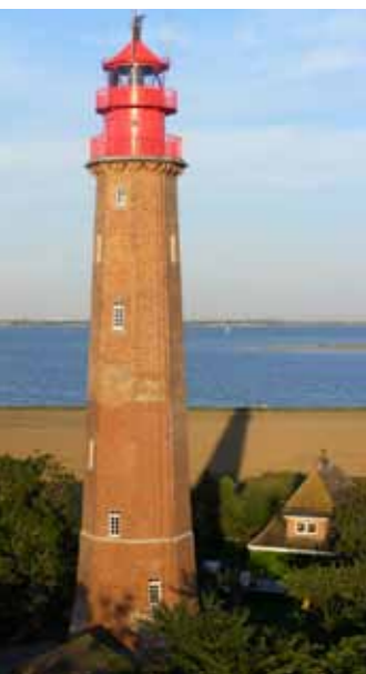
Abb. 1 : Leuchtturm vor der Sanierung; Abb. 2 : Leuchtturm nach der Sanierung, (Foto - H. Leichsering)
