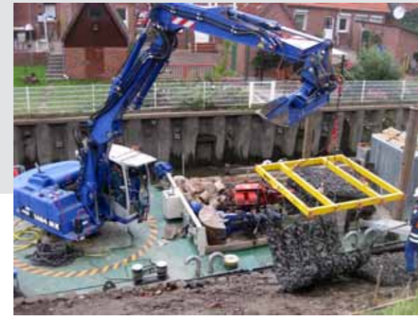
Abb. 2: Verlegen der Steinkammermatten
