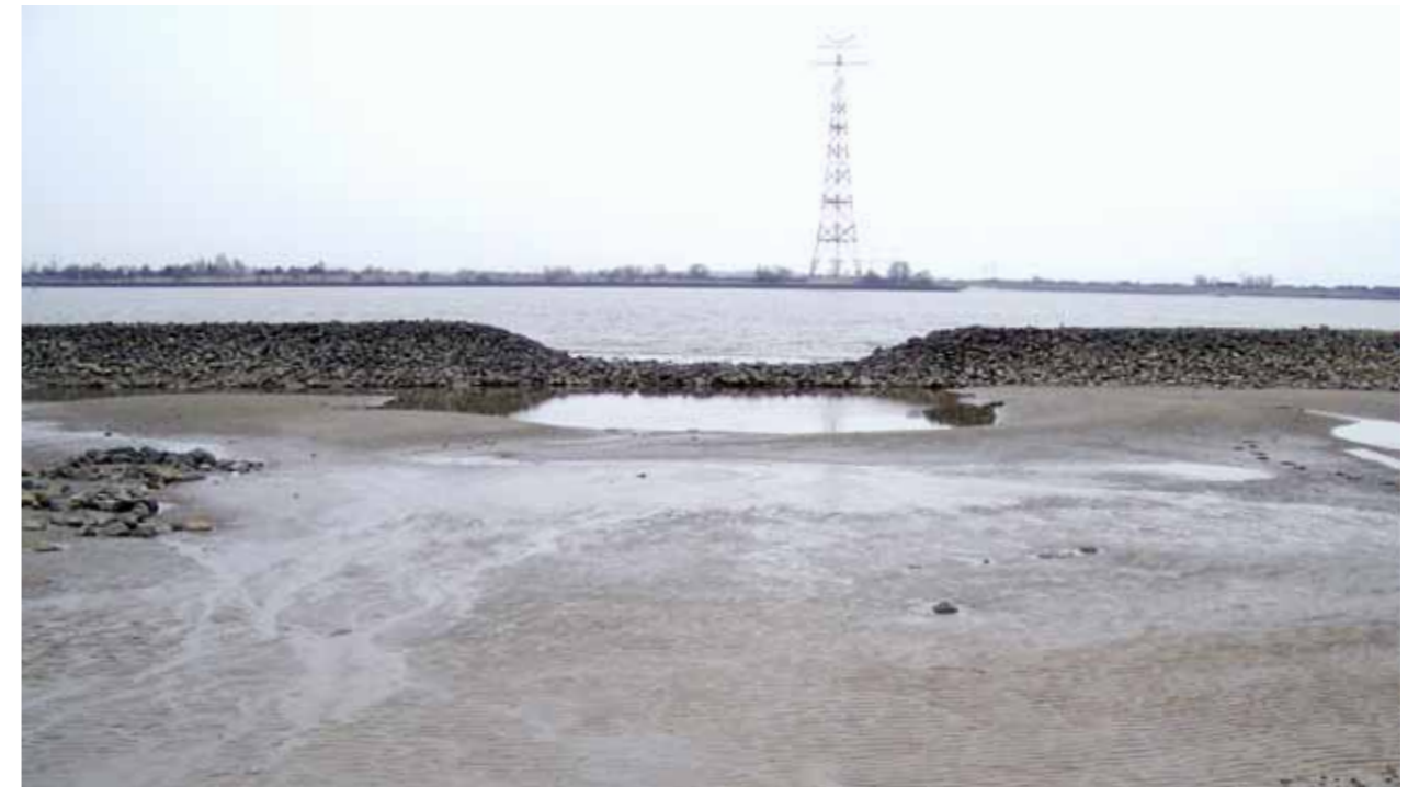
Abb. 8: Deckwerkeinschnitt mit Schwelle
