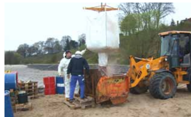
Abb. 2: Einfüllen des Schotters in den Mischer
