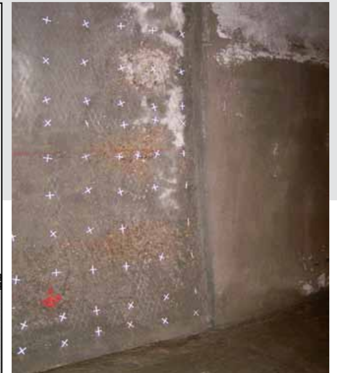
Abb. 5: Neuer Wandaufbau in Arbeitsschritten: Anodennetz und Einbettung mit Brandschutzmörtel (SPCC)
