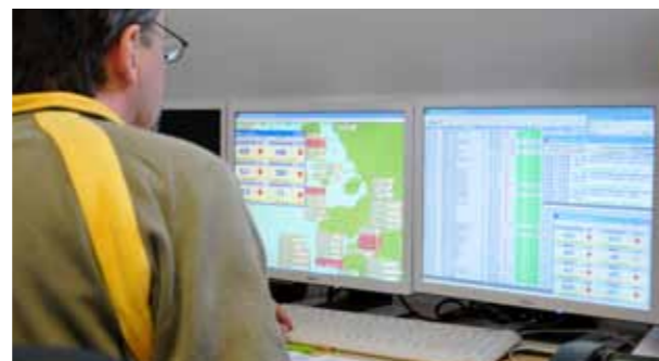
Abb. 2: Überwachung der eingehenden Wasserstandsdaten
