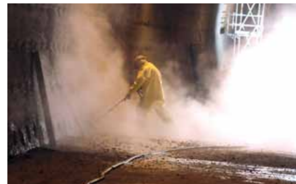
Abb. 2: Handlanceinsatz - Reinigen der Tunnelwände mit Höchstdruckwasserstrahlen
