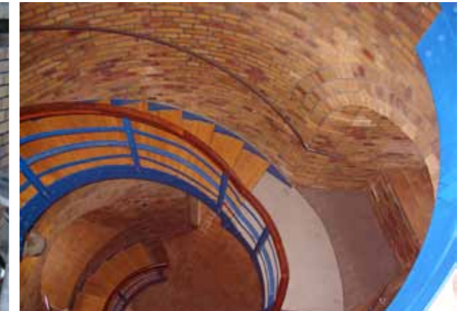
Abb. 4: Treppe nach der Instandsetzung
