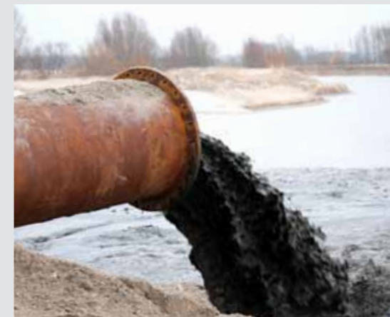
Abb. 1: Spülfeld Mittlere Gieselau beim Spülvorgang
