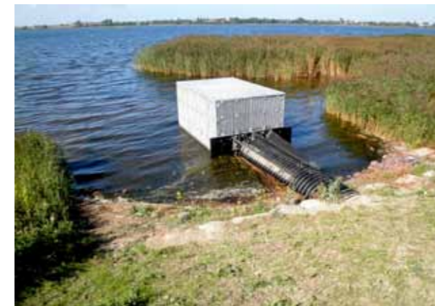
Abb. 2: Einhausung des Verschlussorgans, Blickrichtung vom Seedeich über den Breitling
