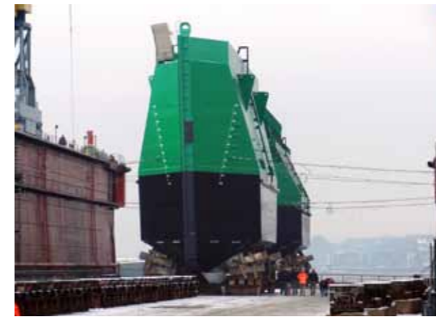
Abb. 1: Neubau der Revisionsverschlüsse für die Kleinen NOK-Schleusen
