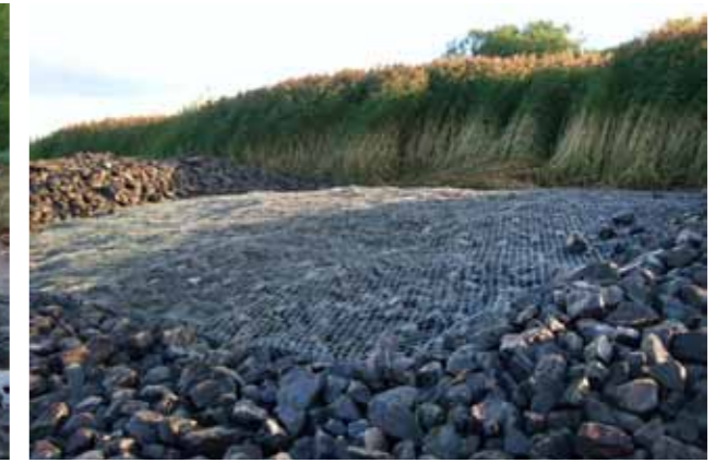
Abb. 4: Befestigte Deckwerksschwelle
