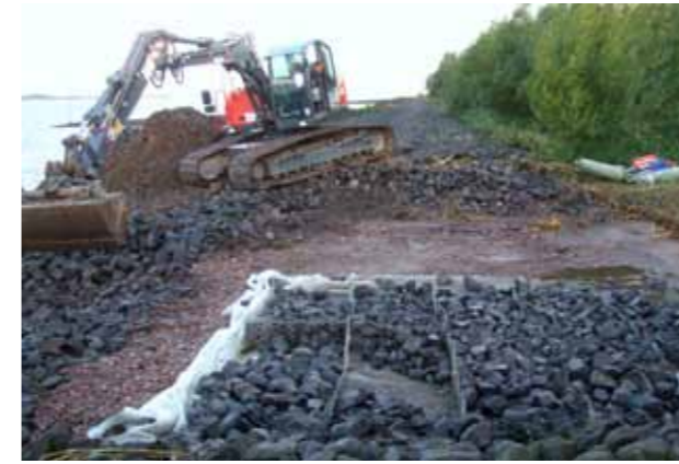
Abb. 2: Befüllen der Steinmatratzen
