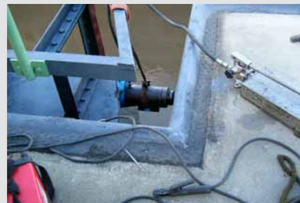
Abb. 2: Fixierung Tor durch Hydraulikstempel I
