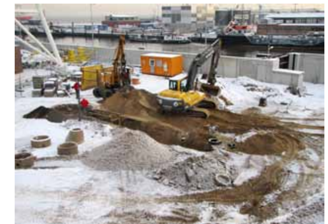
Abb. 4: Baustelle Mitte Dezember 2012
