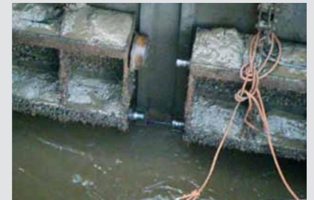
Abb. 6: Umrüstung der Schützrollenlagerung
