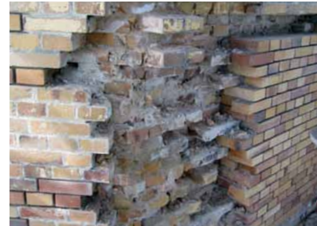
Abb. 3: schadhafte Mauerwerk
