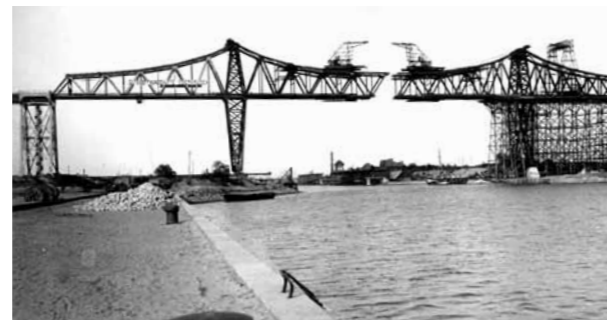
Abb. 2: Hochbrücke im Bauzustand; im Hintergrund die bald ausgedienten Drehbrücken (1913)
