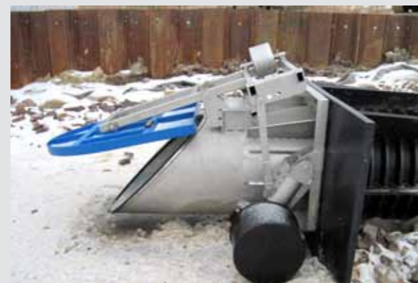
Abb. 1: Verschlussorgan mit Schwimmkörper nach der Montage in der Baugrube
