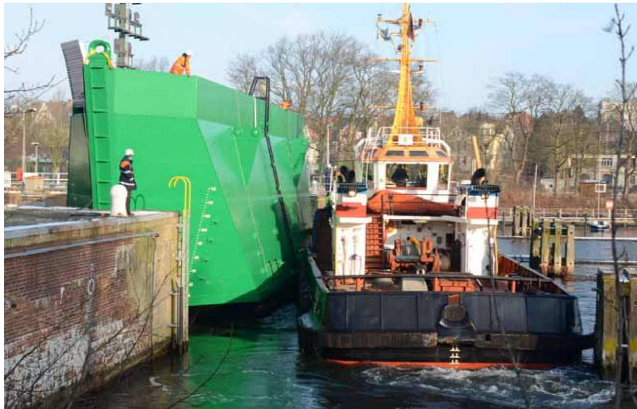
Abb. 3: Einbau der Torverschlüsse in Kiel-Holtenau
