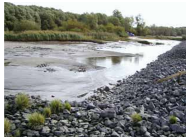
Abb. 7: Deckwerk nach Fertigstellung
