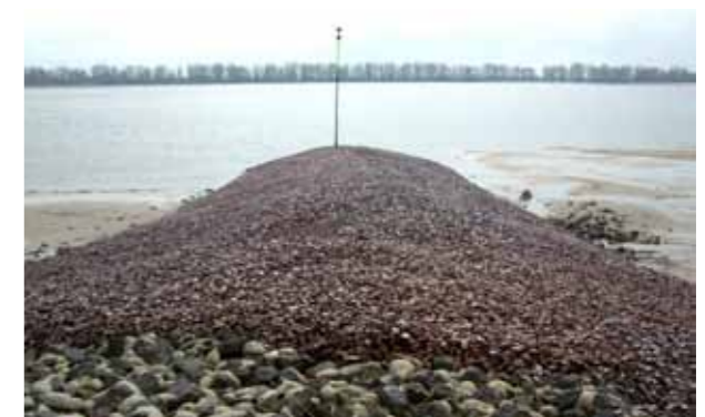
Abb. 6: Sanierter Buhnenkörper
