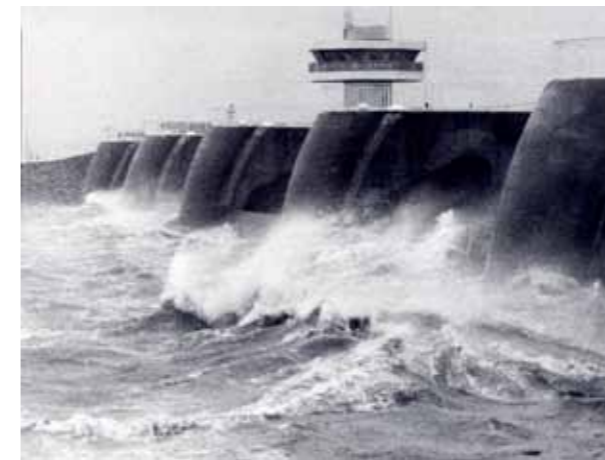
Abb. 1: Eider-Sperrwerk bei Sturmflut
