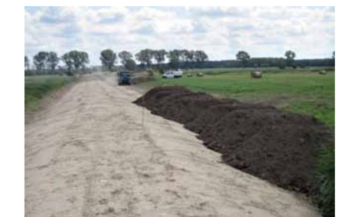
Abb. 4: Flügeldeich vor dem Andecken mit Mutterboden, rechts im Bild das Polderinnere
