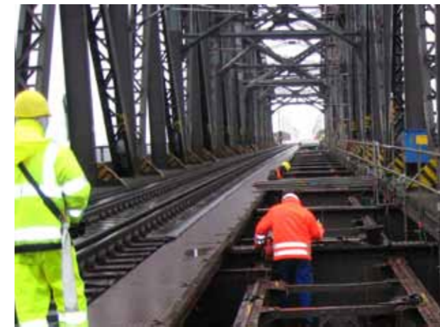
Abb. 3: Kanalbrücke – Arbeiten zur Verstärkung bei eingleisigem Bahnbetrieb (2012)
