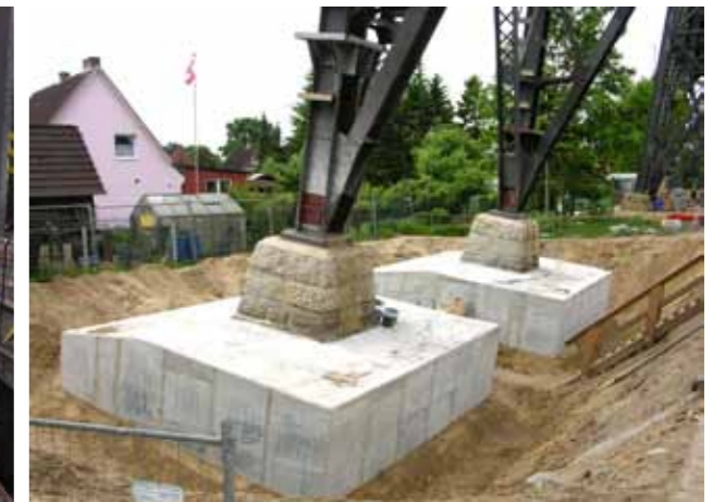
Abb. 4: Pfeilerfundamente – Verstärkung, Ausführung an insgesamt 212 Stück (2012)
