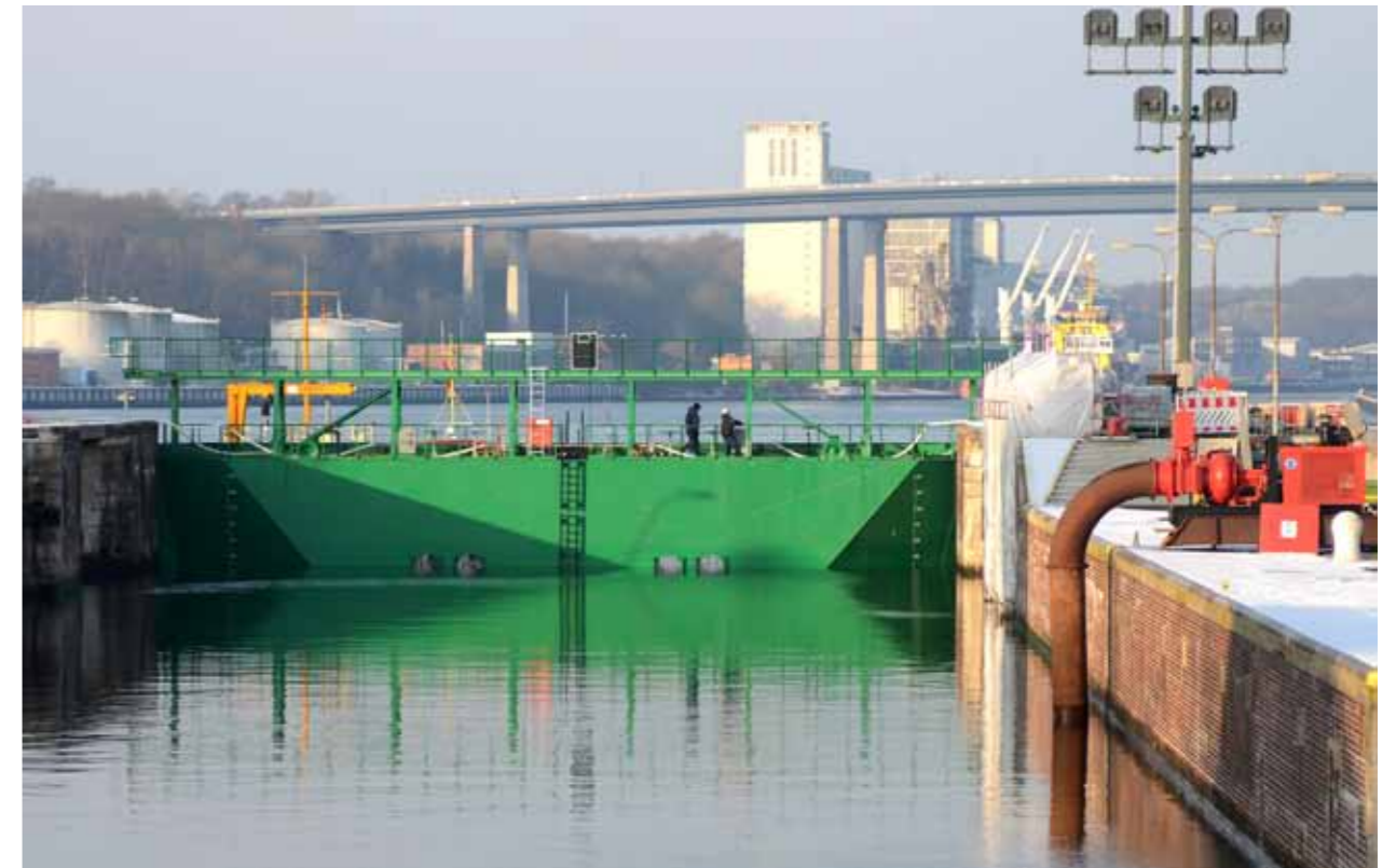
Abb. 4: Absenken der Torverschlüsse in Kiel-Holtenau
