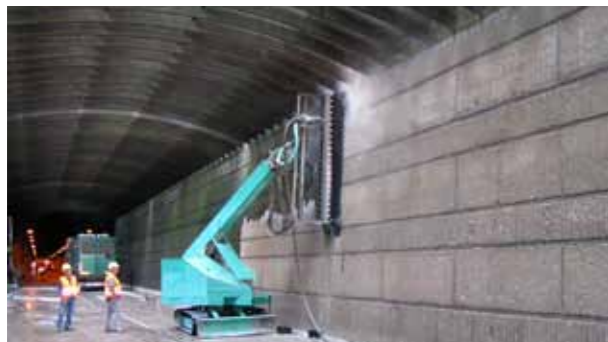
Abb. 1: Robotereinsatz - Waschen der Tunnelwände mit Höchstdruckwasserstrahlen
