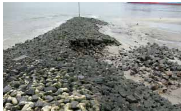
Abb. 1: unterstromseitige Buhnenschäden
