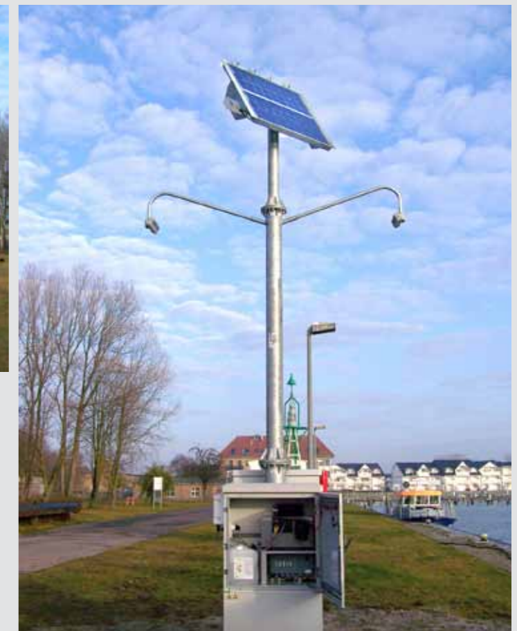
Abb. 4: Schaltschrank mit Brennstoffzelleneinbau.
