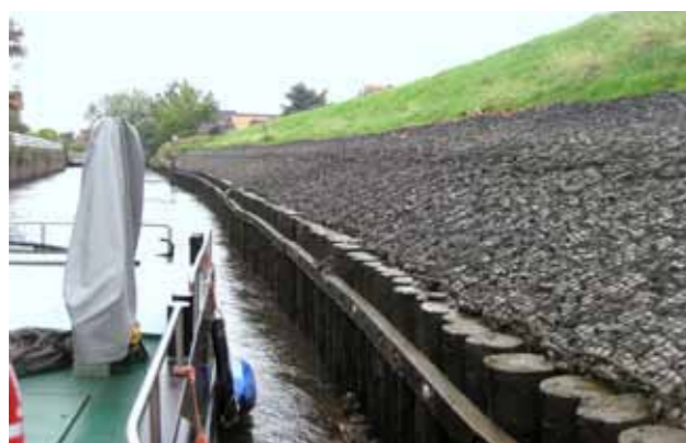
Abb. 1: sanierte Ufersicherung
